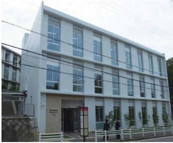
完成した増築棟（自由ヶ丘キャンパス別館）
