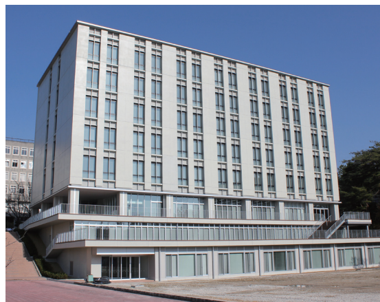
完成した新2号館。南側から
