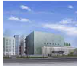
記念館（左が完成パース図）の写真は上右が1階「ものづくりエリア」での授業、左で中右が3階記念ホール、左が空調等の導線が一目で分かるカラフルな配管。下右が3階体育館、左が2階音楽室。
