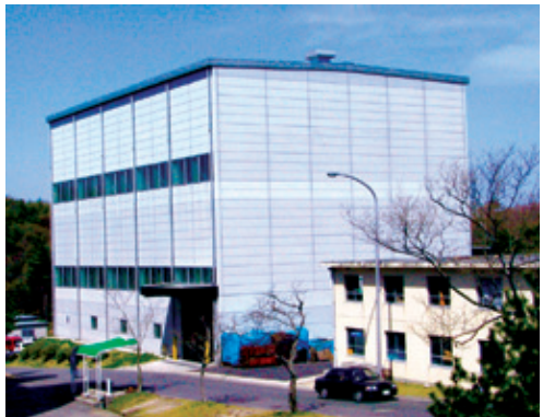
大学の施設としては国内で最大級を誇る耐震実験センター
