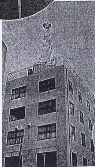
大学本館屋上にある同報無線局送信鉄塔 ↑
